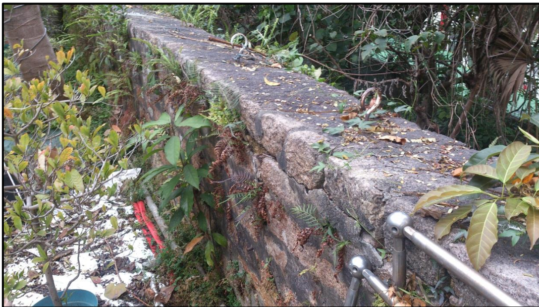
圖 3：有砂漿接縫的現有古老石牆
