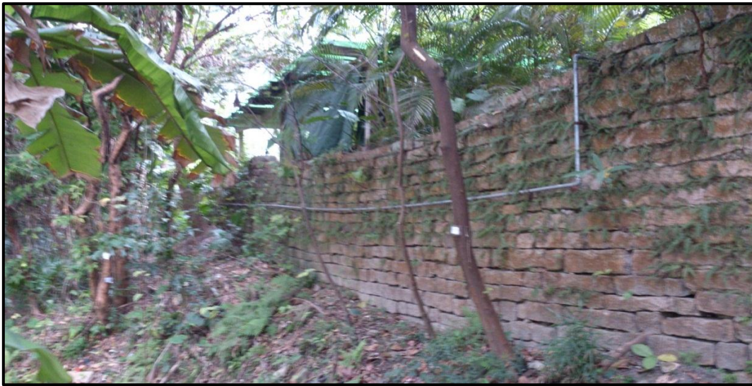
圖 2：沒有砂漿接縫的現有古老石牆
