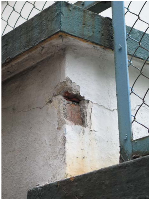
鴨巴甸街邊界牆中間支柱的外露紅磚
