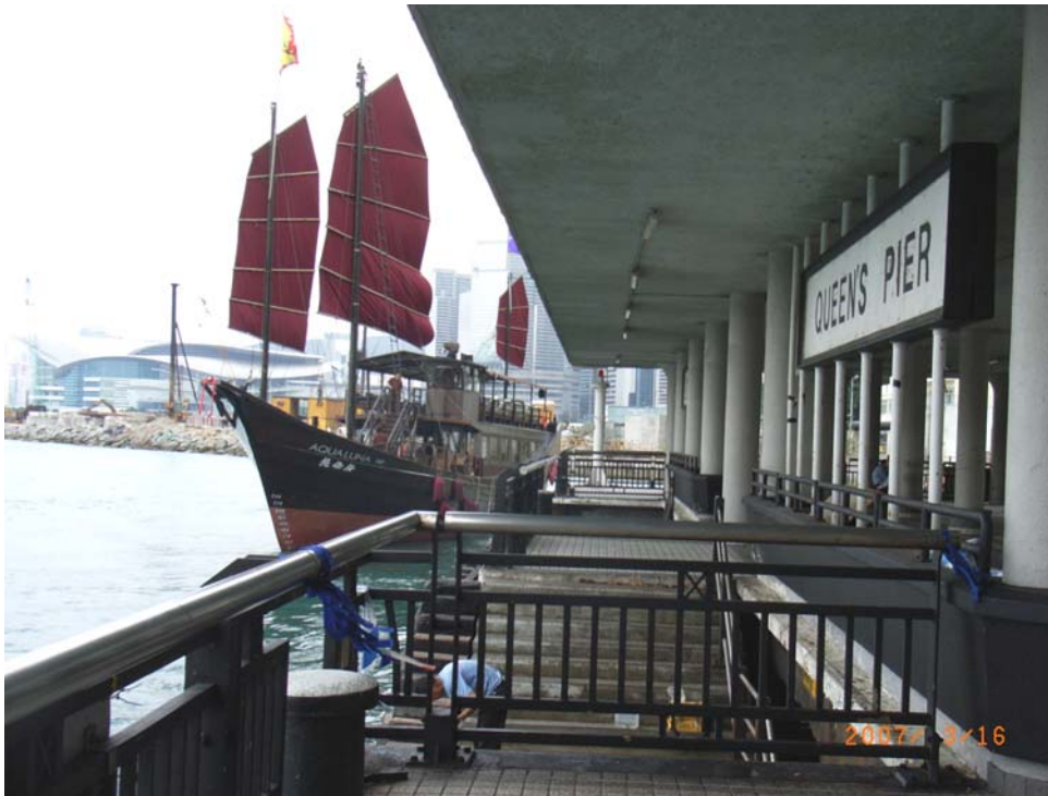
登岸階梯和繫纜柱
