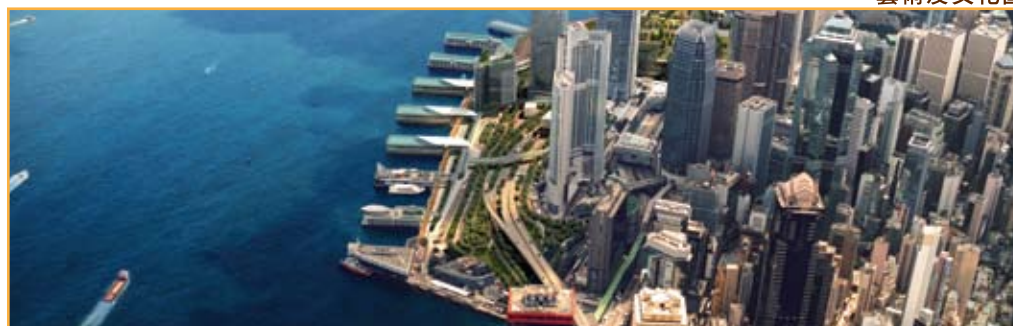
碼頭堤岸走廊
