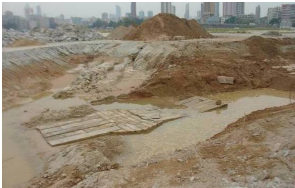
二〇〇八年五月出土的龍津橋石板和橋墩照片
