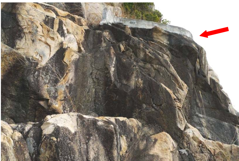
石刻上方的水泥擋水堤
