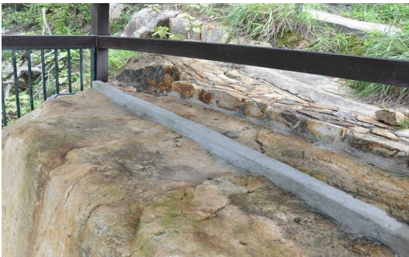
石刻上方的水泥擋水堤
