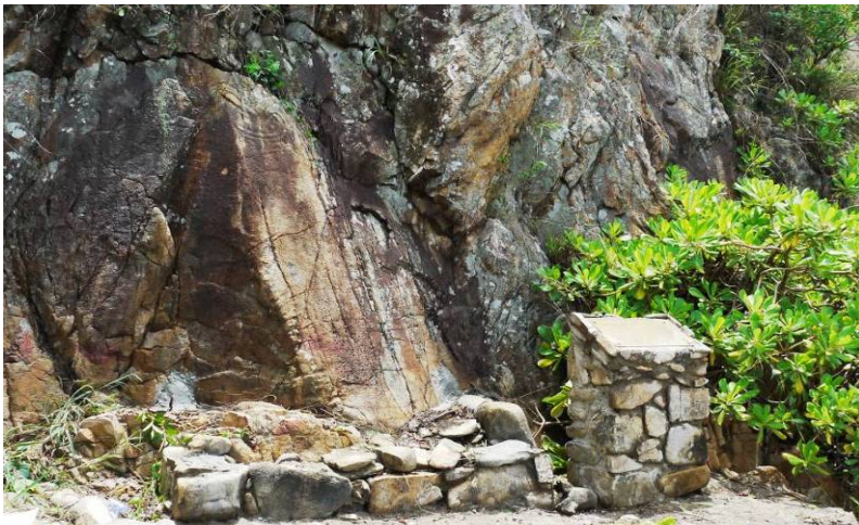
拆除保護罩後的石刻
