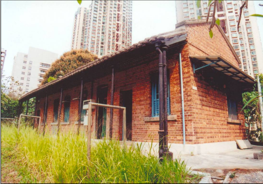
插圖 1：工人宿舍 - 正立面(南立面)及東立面
