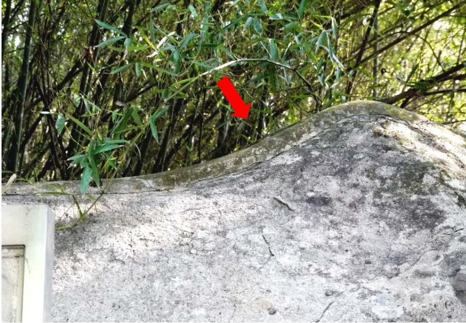
照片 14：刻石上方的水泥擋水堤
