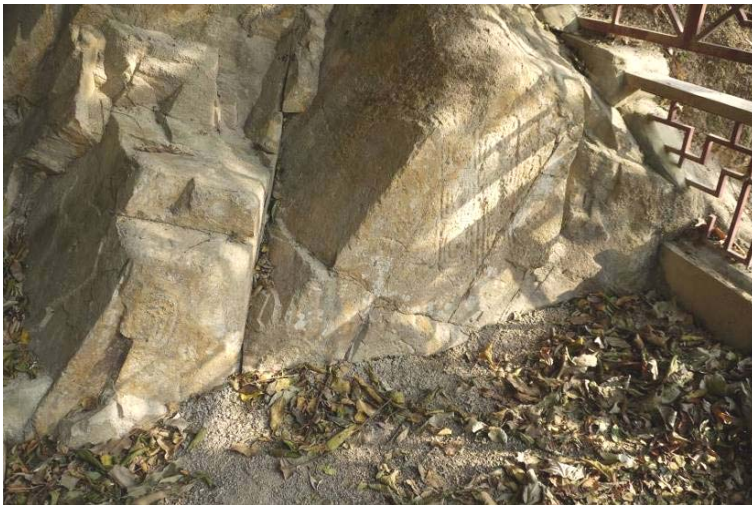
部分石刻被泥土掩埋
