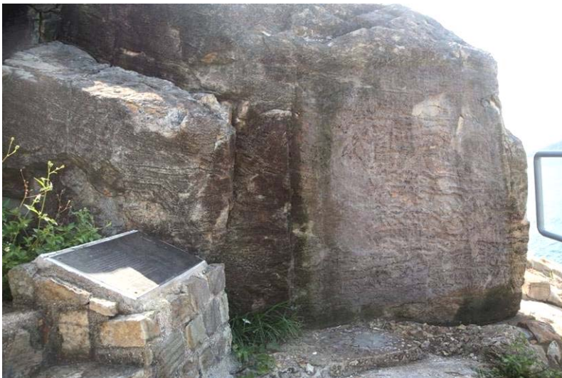
拆除保護屏幕後的石刻
