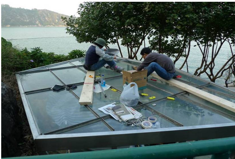
照片 9：重新封好玻璃上蓋，以防止雨水滲漏
