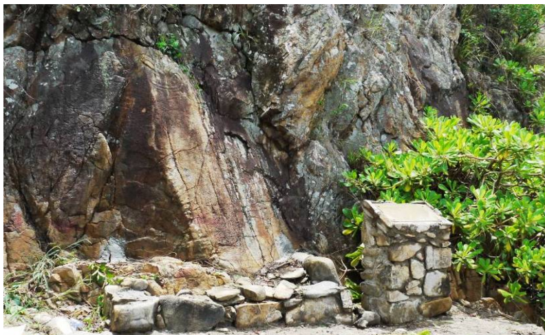
拆除保護罩後的石刻
