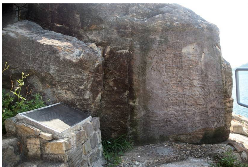
照片 13：拆除保護屏幕後的石刻
