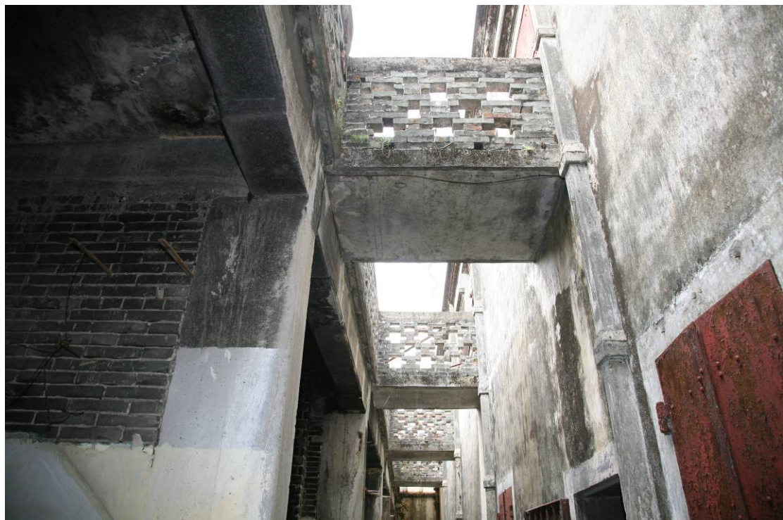
主樓與屋後附屬建築的頂層平台之間以磚砌小橋相連
