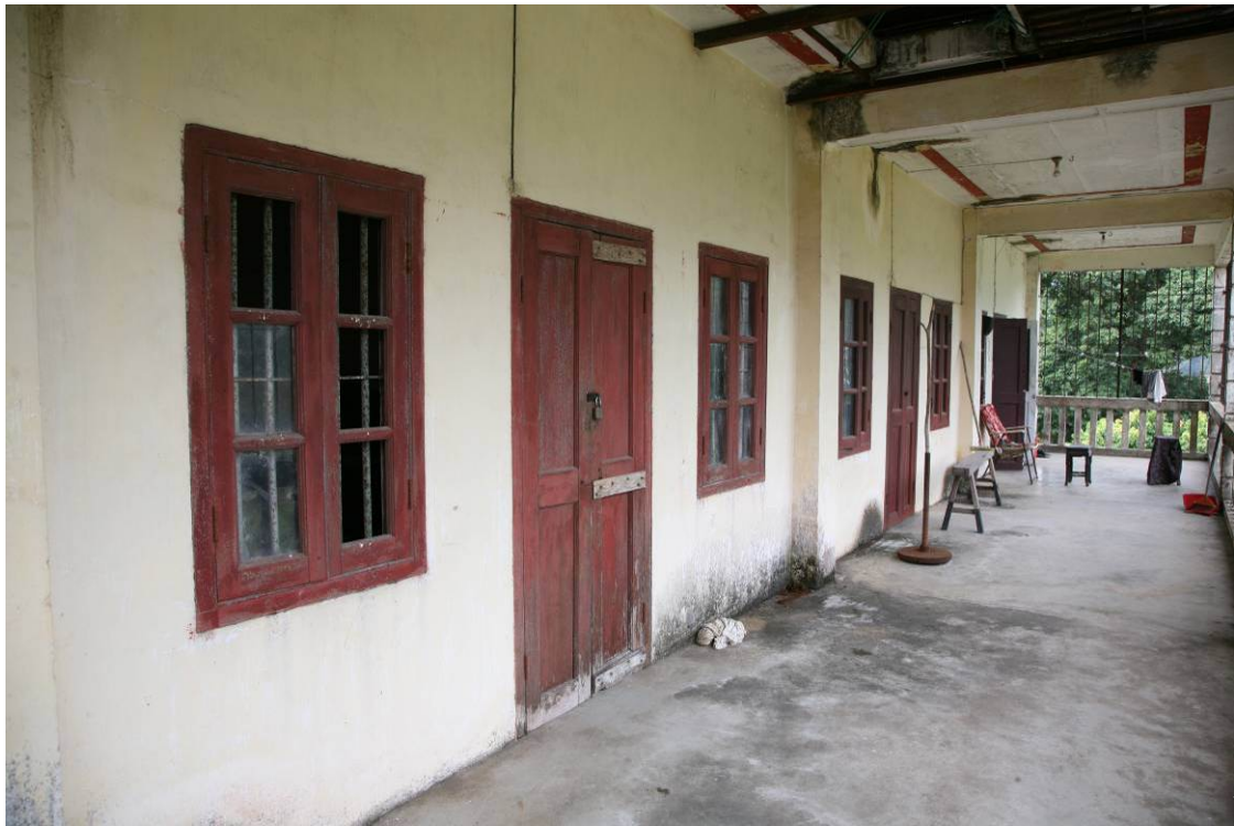
樓上的共用外廊
