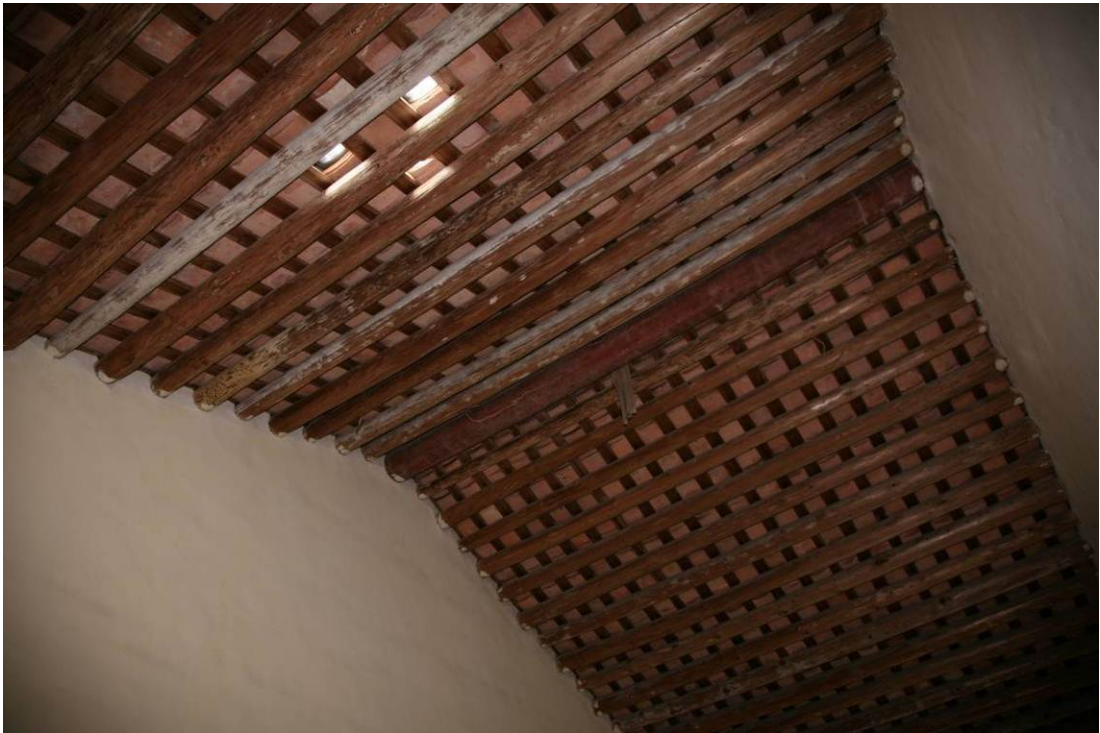
以木桁支撐的 中式 金字瓦頂
