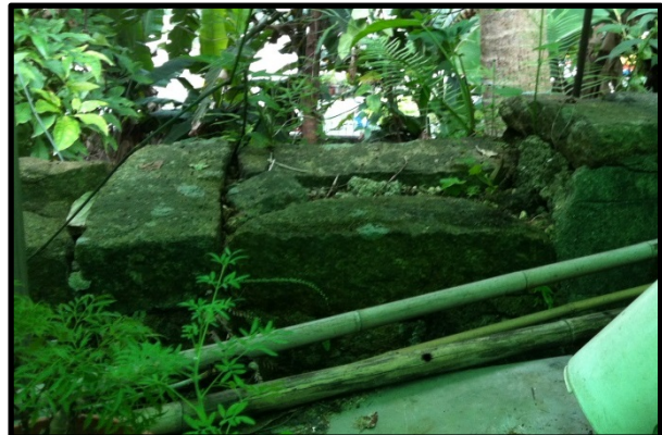
圖 5：受影響石牆的照片和受損壓頂石的特寫
