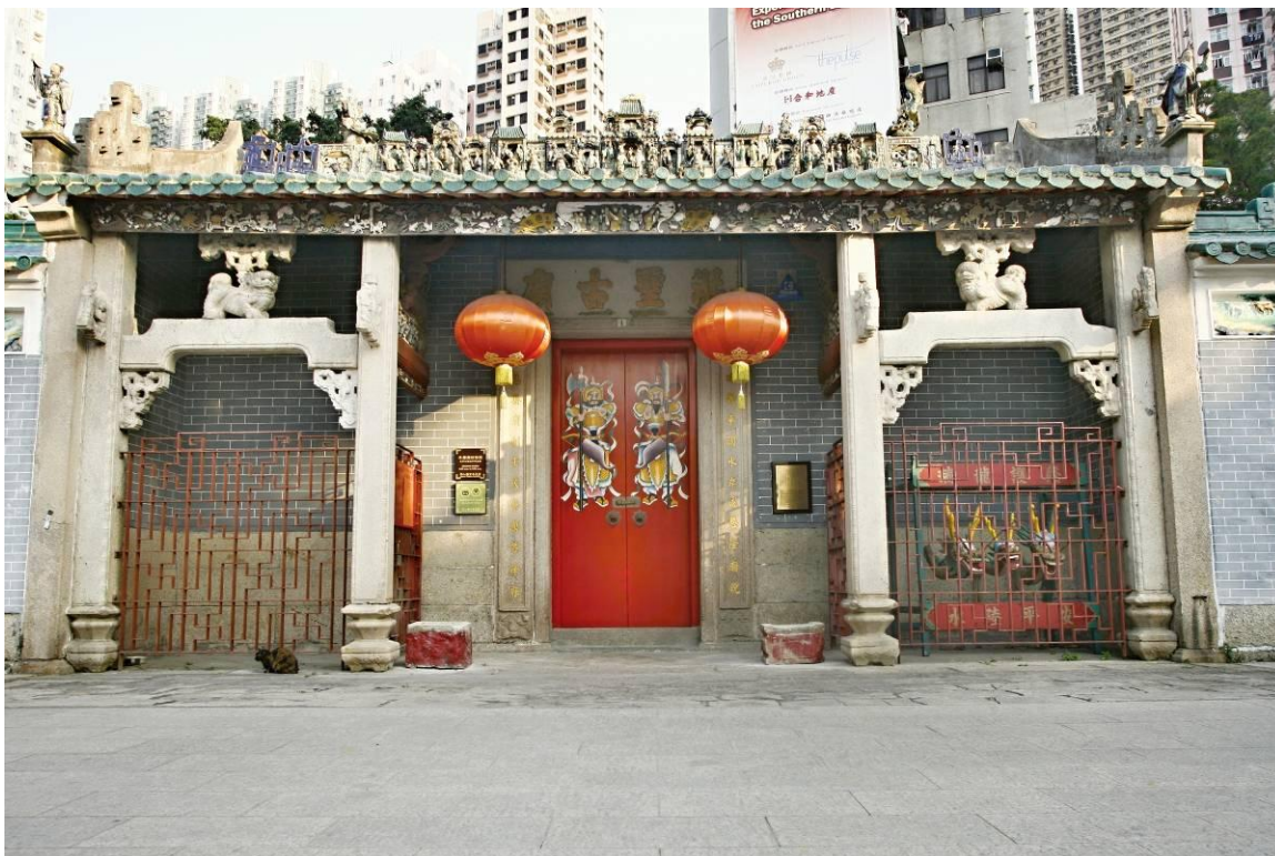
前殿的前檐由一組飾以精緻雕刻的花崗岩石柱和木樑架支撐
