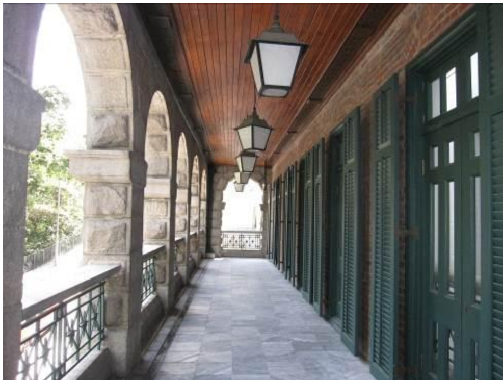
外廊的吊燈、木板天花和百葉木門 均於二〇〇二年修繕時加上
