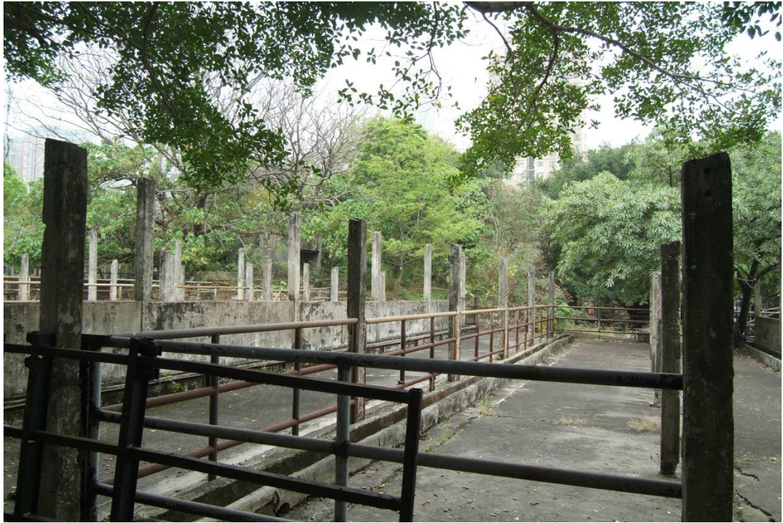
圖三. PB623-PB628 (混凝土柱區)
