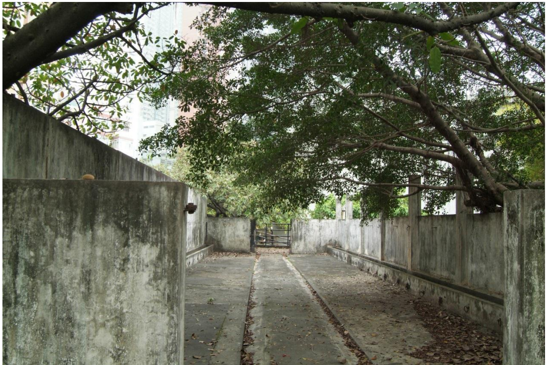
圖四. 現存的 PB829 (混凝土牲口棚)
