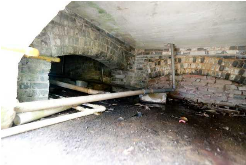
為通風而設的底層結構。 圖中可見青磚牆，以及支撐樓板主要結構的磚拱。
