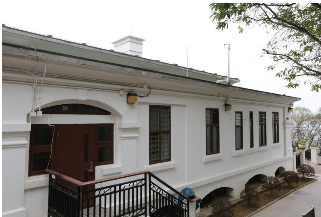
原有的撐高式斜屋頂改建成兩級平頂。
