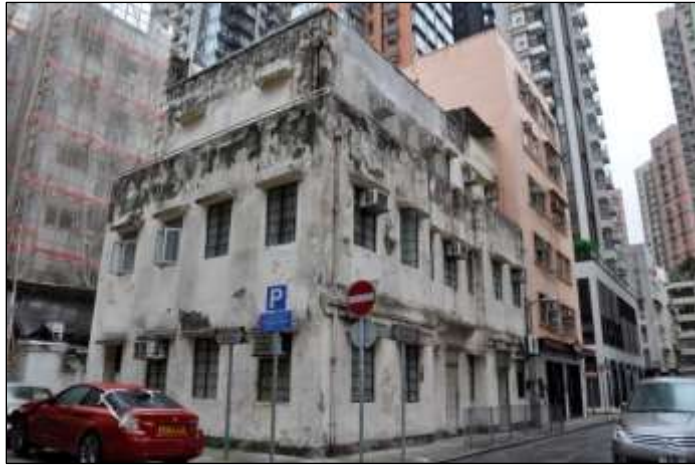
正立面和側立面 (從書館街與布朗街街角望向建築物)
