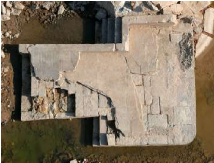
圖 12：在龍津石橋碼頭花崗岩結構上的 1892 年、1910 年代、1920 年代、1930 年代的混凝土後期修建部份。
