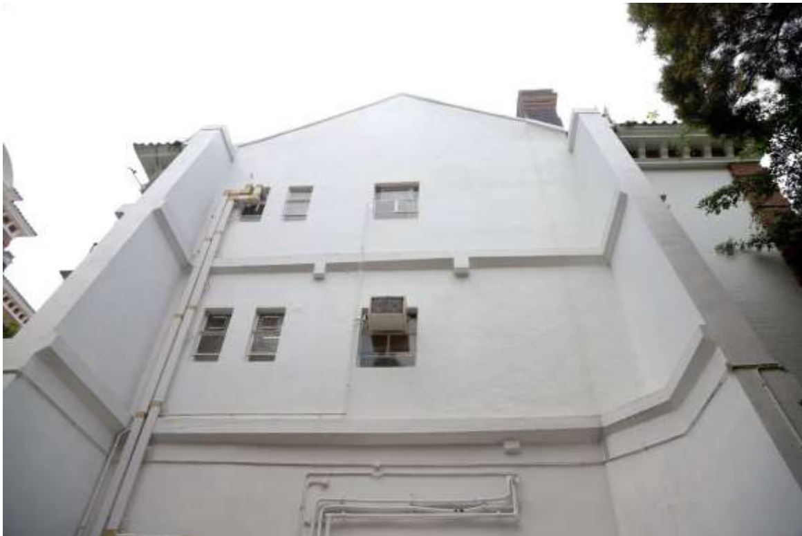
一九六六年發生嚴重山泥傾後，倒塌部分加建兩道扶壁
