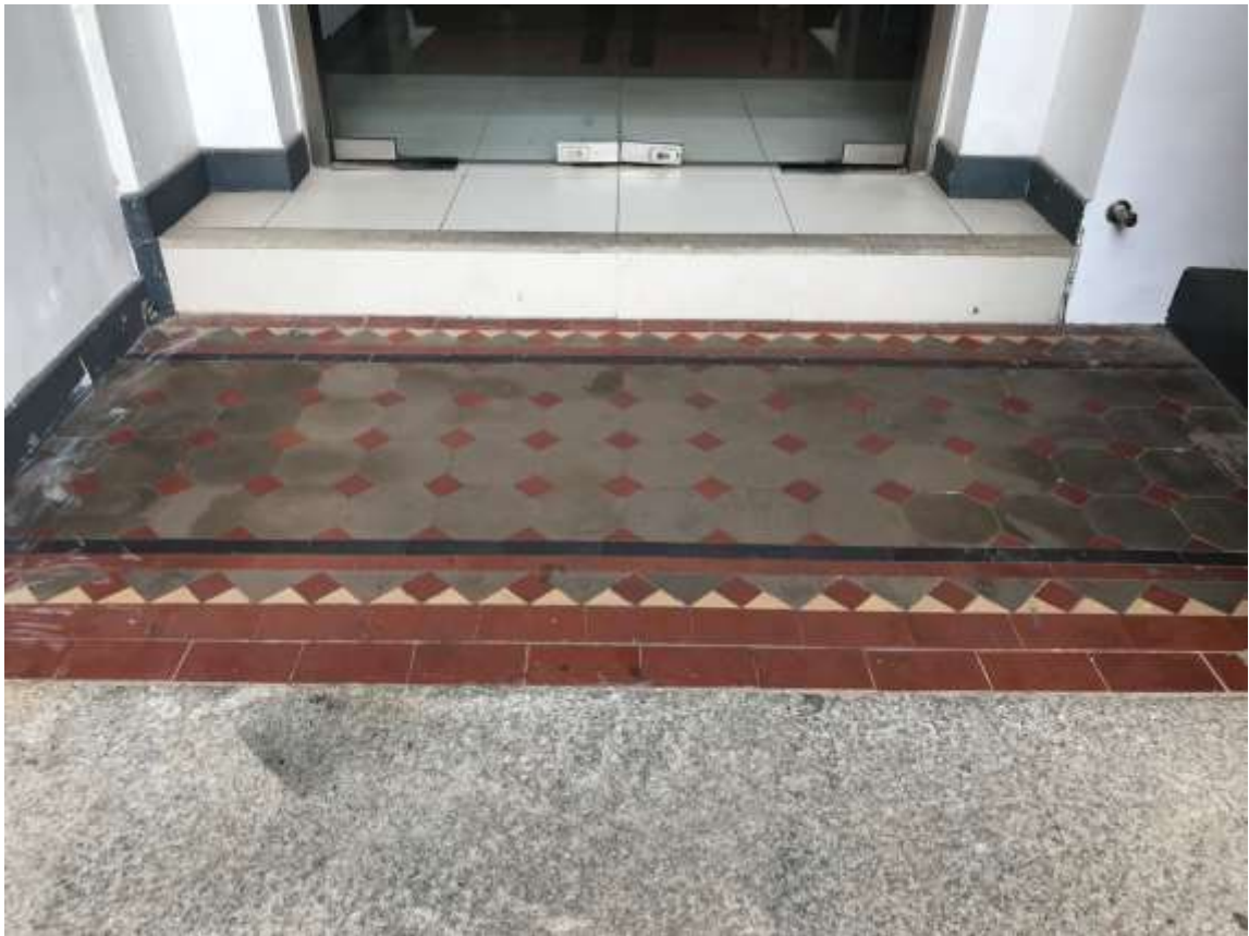
北立面遊廊的舊地磚
