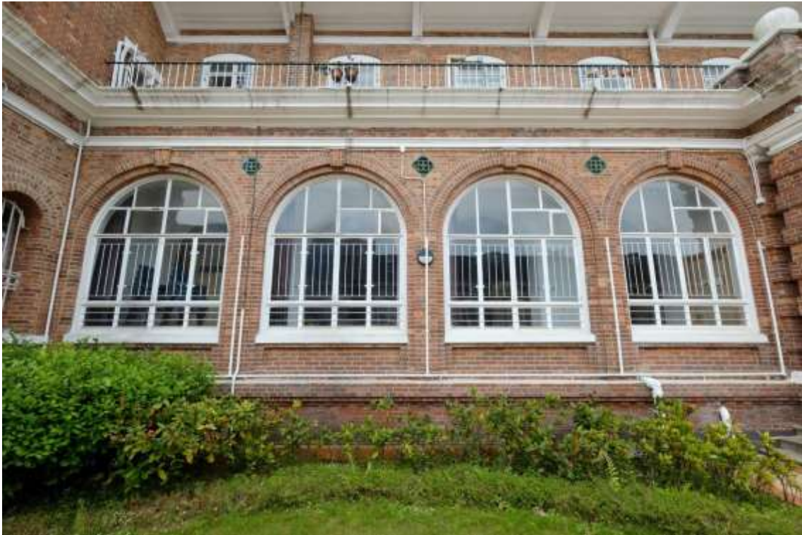
地下被圍封的遊廊（北立面）
