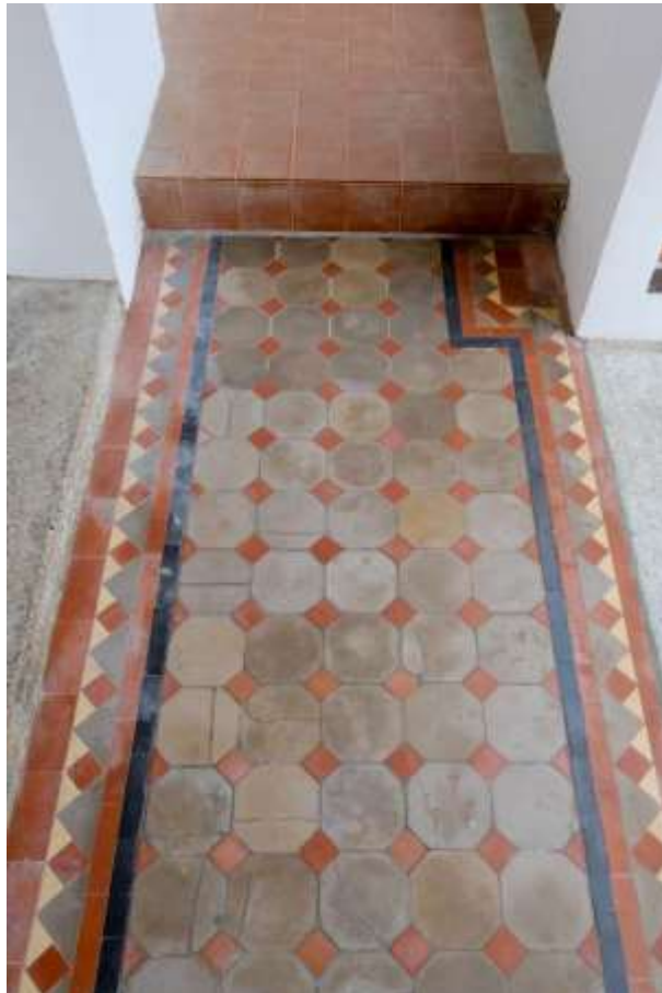
北立面遊廊的舊地磚
