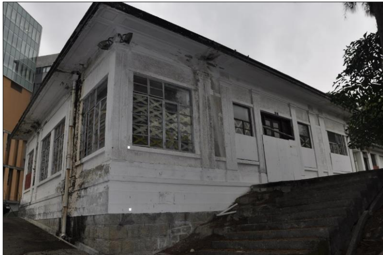
主樓(Main Block)西南角
