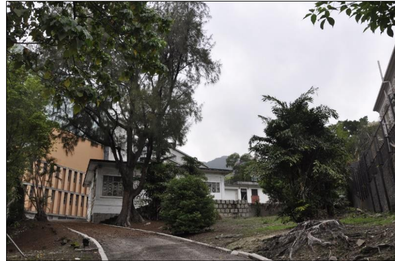
從入口望向主樓(Main Block)和擴建部分(Extension)南立面
