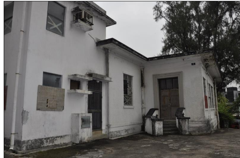
主樓(Main Block)主入口和擴建部分(Extension)西立面
