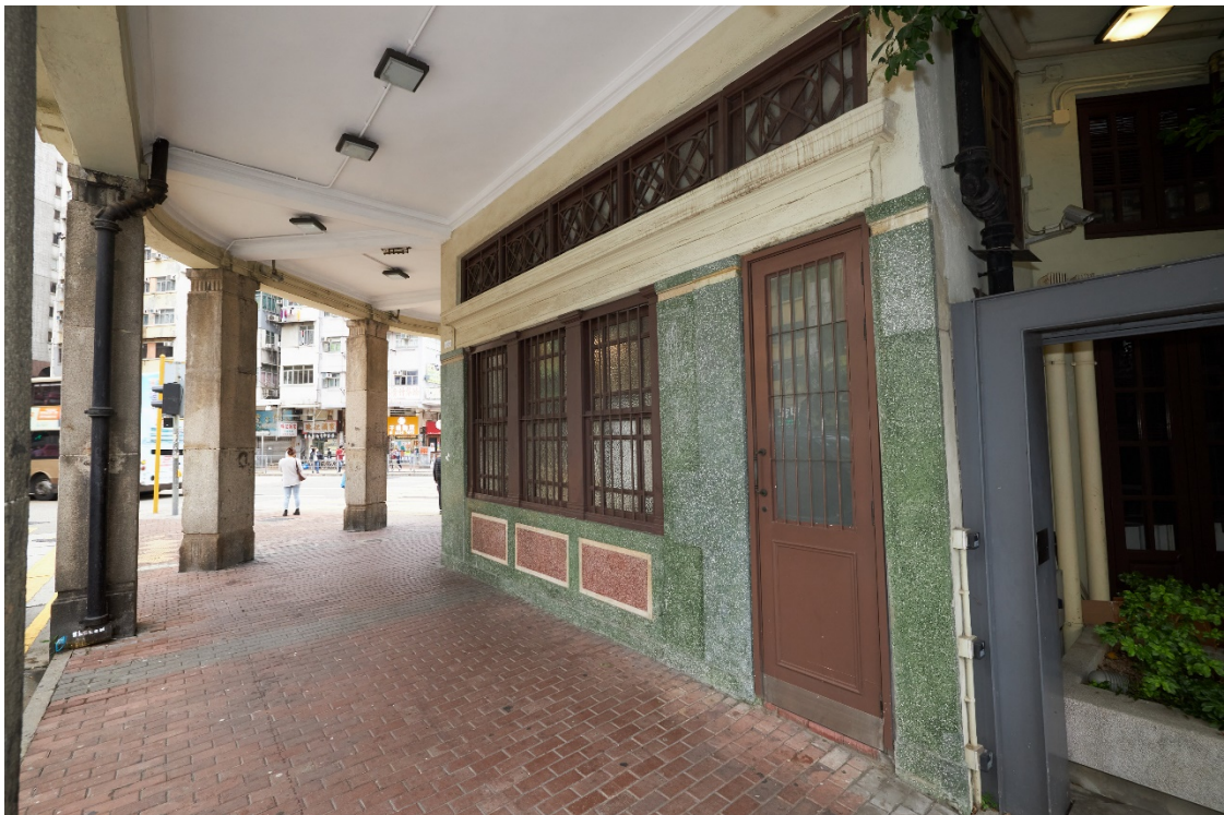
遊廊由地下的花崗岩石柱支撐， 延伸到公共行人路上，形成迴廊。
