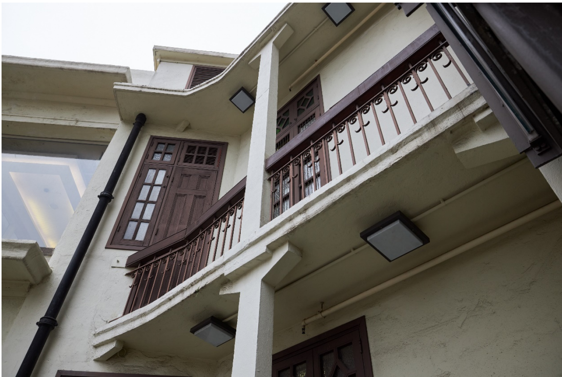
背立面外廊以混凝土橫樑支撐，欄杆的裝飾一致。
