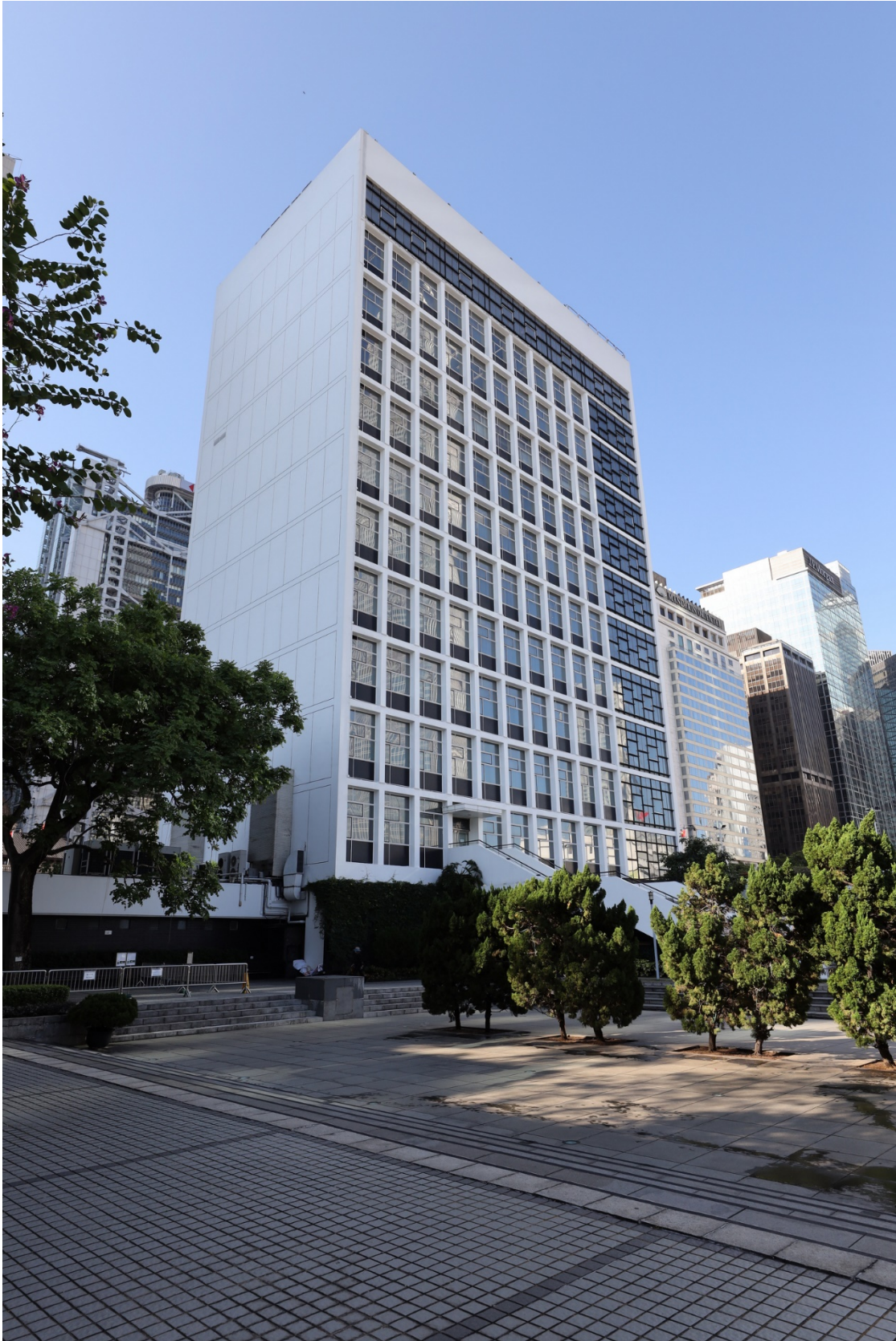
高座北立面外牆為「混凝土框架內簡單而具規律性的窗戶排列」，東立面外牆則以白色批盪。
