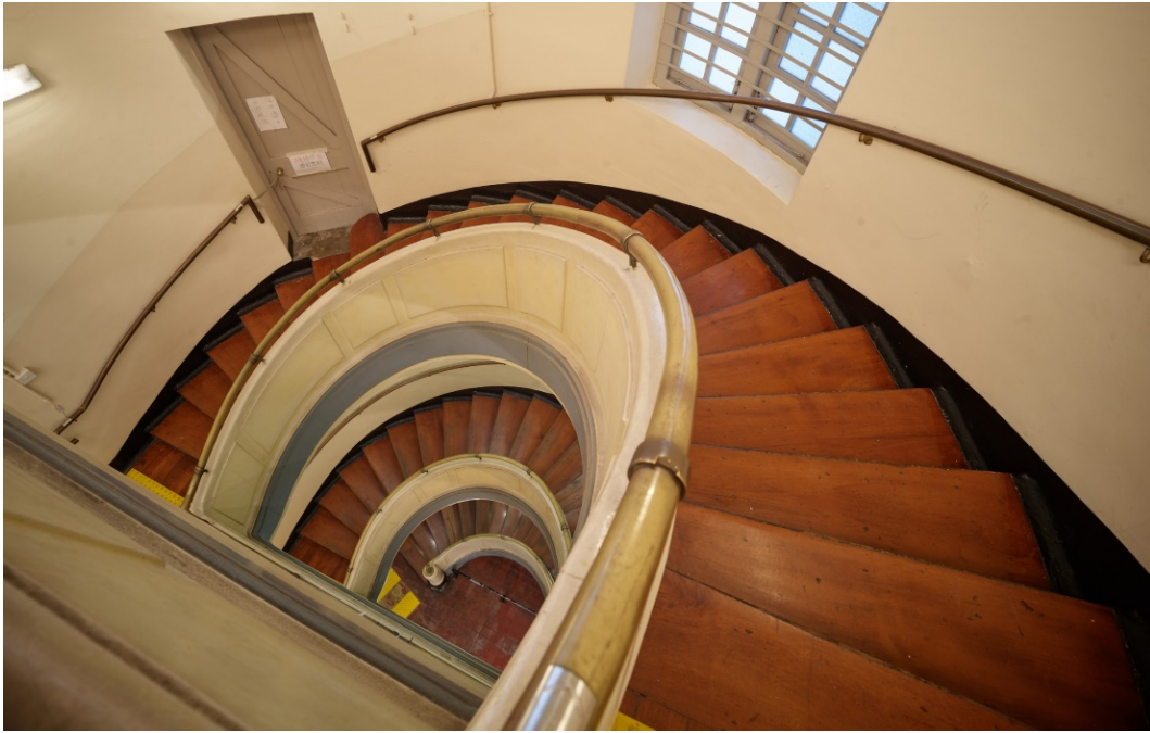
螺旋形主樓梯連混凝土欄杆及金屬扶手
