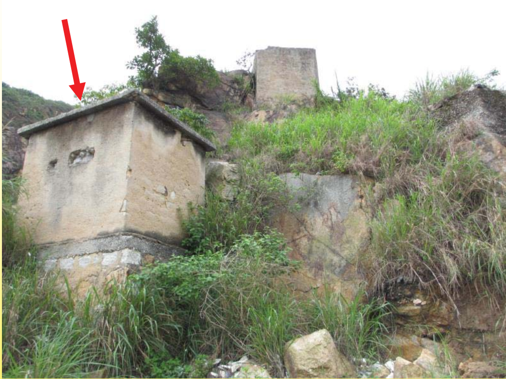
混凝土建小屋（危險品倉庫） Concrete Hut (Dangerous Goods Store)
