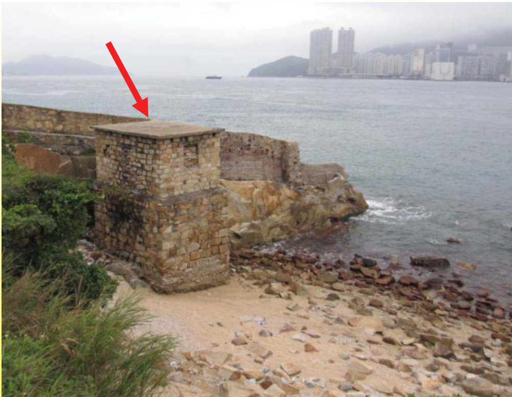
石建小屋（危險品倉庫） Stone Hut (Dangerous Goods Store)
