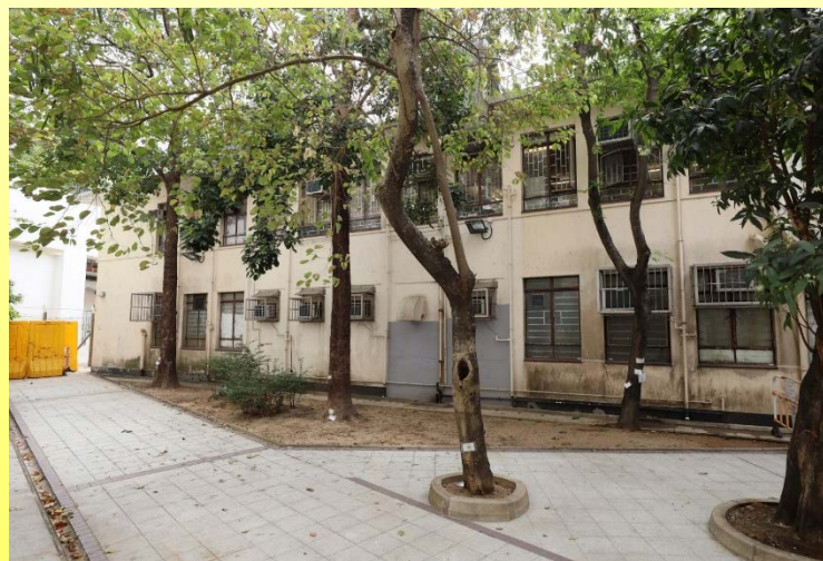
石硤尾健康院的北面部分西主立面
