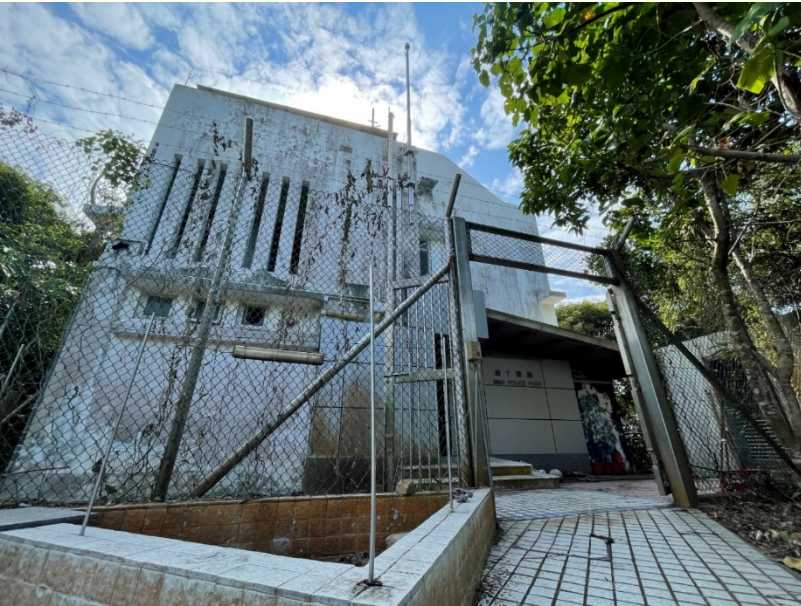
北立面 North façade
