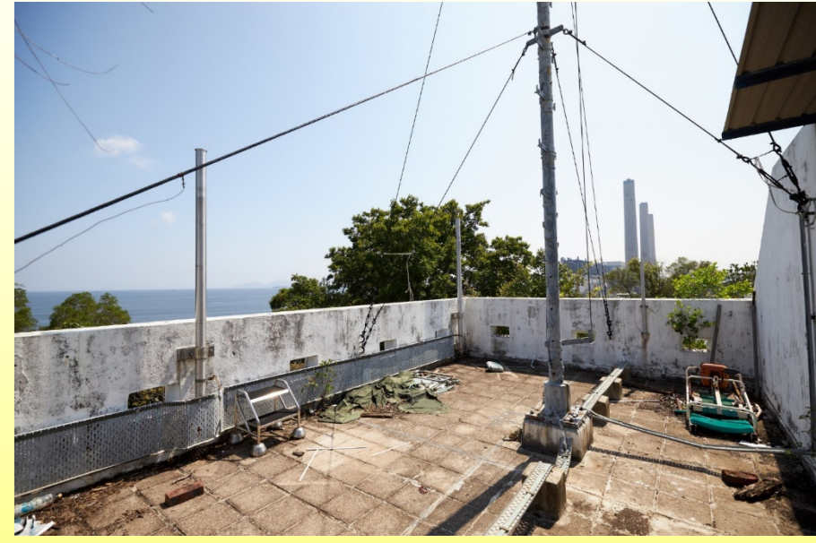
天台 Roof floor
