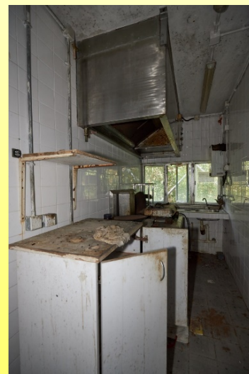
地下廚房 Kitchen on G/F
