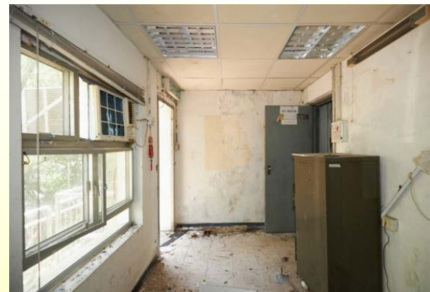
地下警崗主管辦公室 N.C.O. in charge's office on G/F
