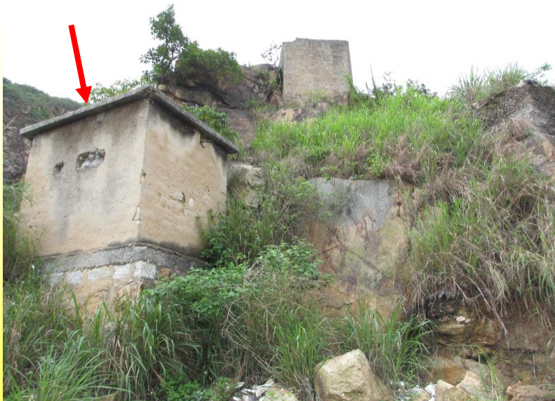
(13) Concrete Hut (Dangerous Goods Store)
